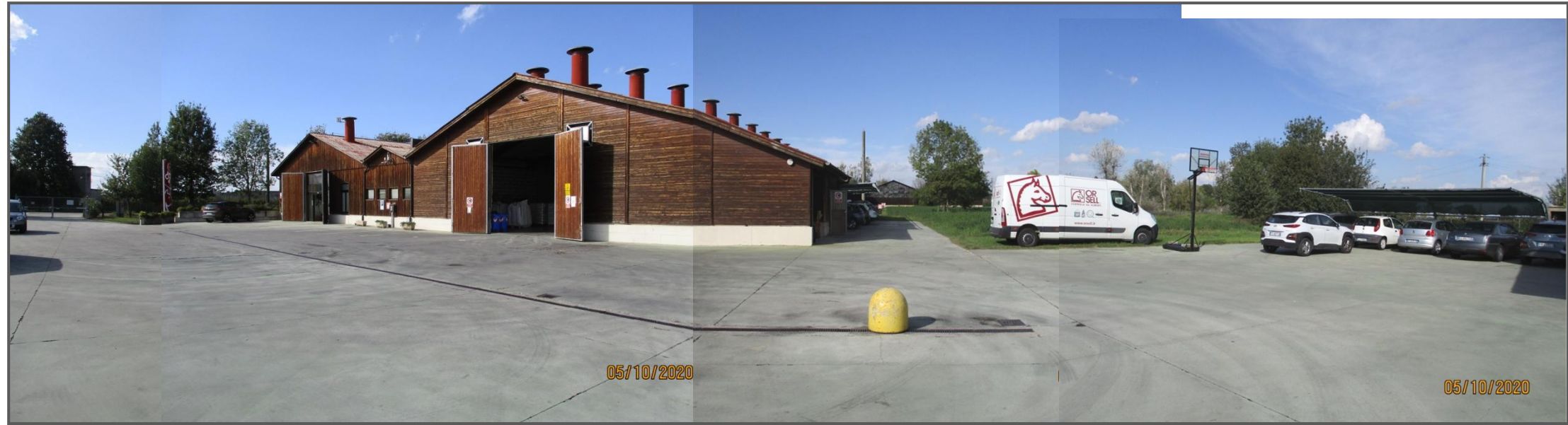
10 - Vista verso nord del lato interno
