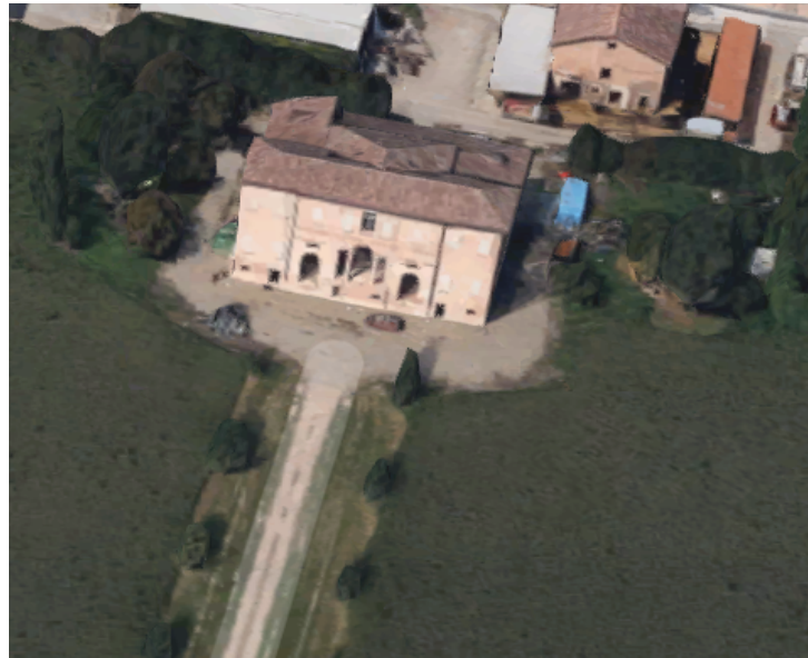
Foto n.1 – Villa Casino De' Vecchi, vista dall'alto
