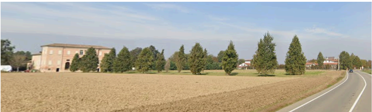
Foto n.2 – Villa Casino De' Vecchi, vista del viale alberato di accesso
