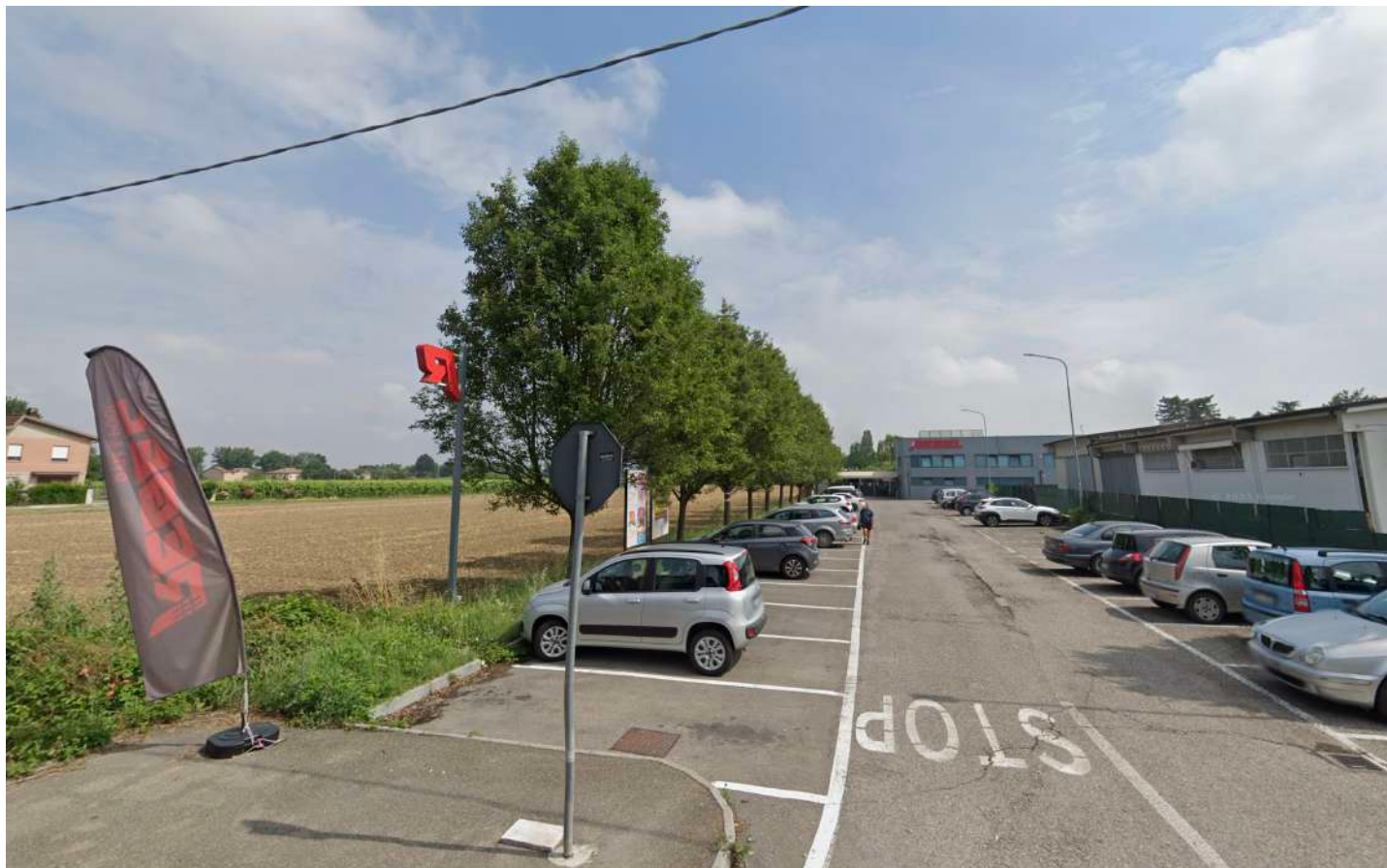
FOTO VIA CORTE INGRESSO PARCHEGGIO ANTE-INTERVENTO
